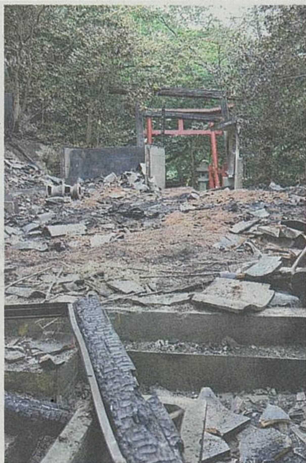
15日の火災で焼失した二ツ岩大明神のお籠もり堂。鳥居の奥に本堂がある=佐渡市相川下寺町
